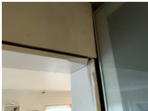
Feilmontert laminat med gliper i skjøter
