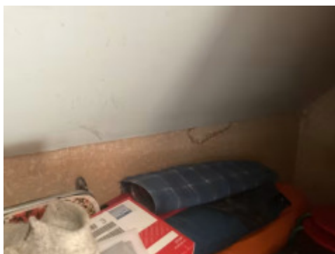
Registrert vannmerker på vegg i kott 2 etg.
