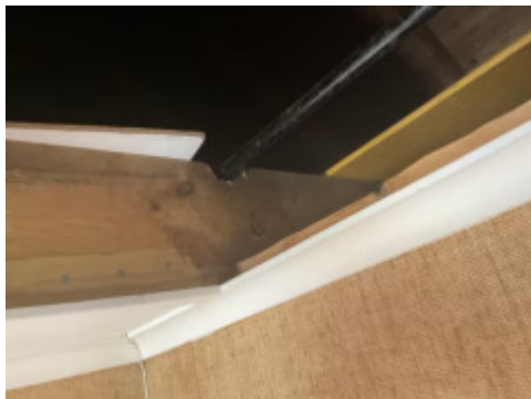
Uisolert loftloftluke.
