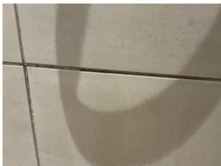
Eksempel på riss/missfarging
