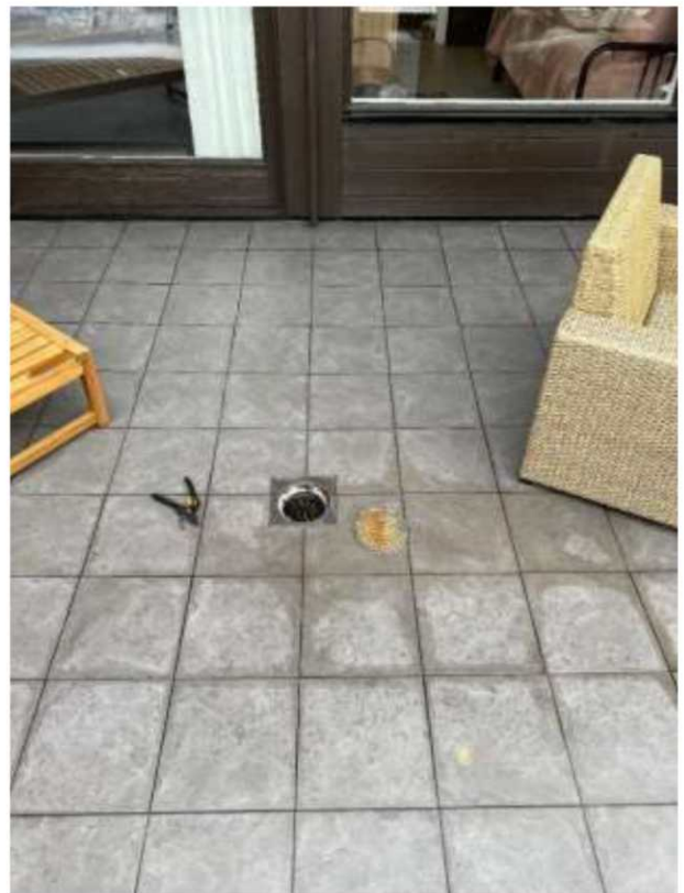
Sluk på terrasse i 2. etg.(TN2)
