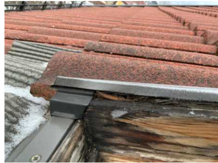
Råteskade takvindu
