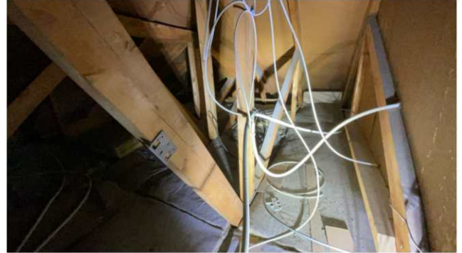
Det som er synlig har god lufting og ingen tegn til fukt.
