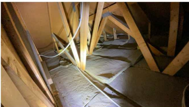
Det som er synlig har god lufting og ingen tegn til fukt.
