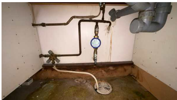
Bilde: Mer enn halvparten av forventet brukstid er passert på innvendige vannledninger.
