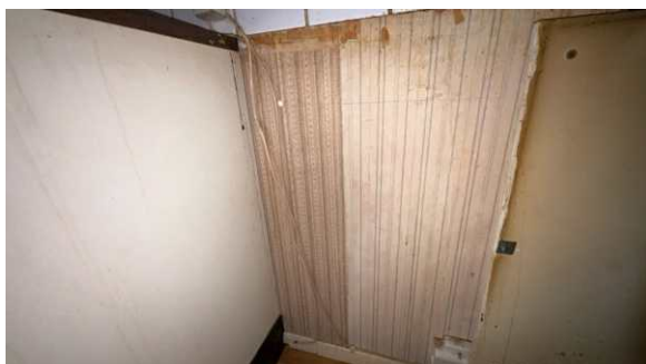
Bilde: Kabler i leiligheten er ikke tilstrekkelig festet.
