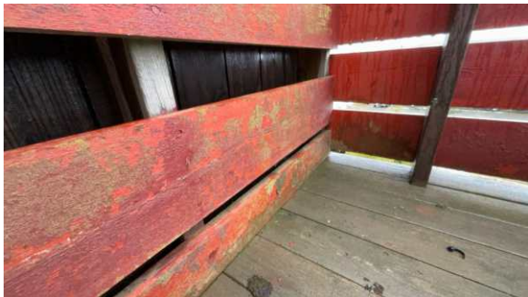
Bilder: Værslitt trevirke/trepaneler.
