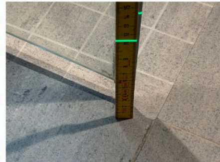
Fallforhold - ca. 112 mm overkant gulv ved dusjsone
