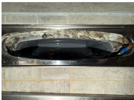
Slukrenne ved vegg i dusjsone. Synlig membran
