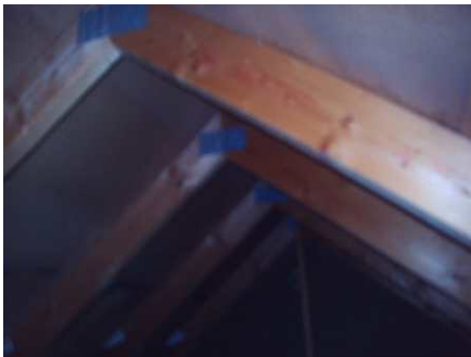
Deler av takkonstruksjonen.
