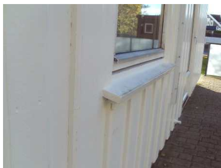
Deler av kledningen med tilhørende belistninger.
