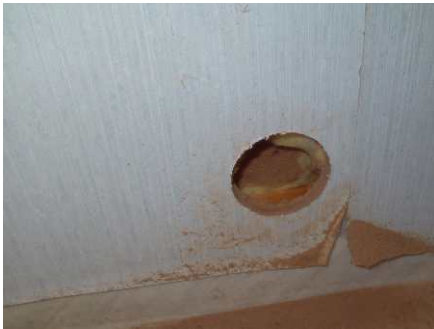
Hulltaking i vegg mot bad.
