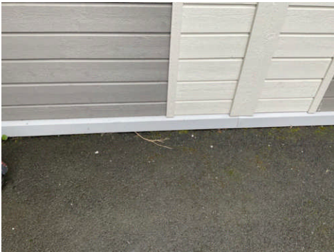
Bilde mot fasade/grunnmur
