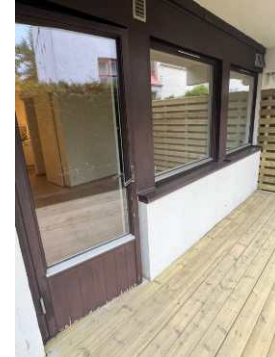
Vinduer og terrassedør sett utenifra
