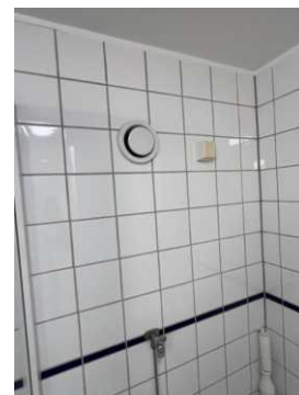
Antatt tilluftsløsning fra ventilasjonsaggregat
