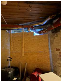
Enkel sikring/avdeling til del av stor kjellerbod.
