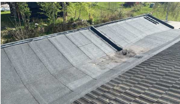
Sveiset papp på tilbygg mot øst.
