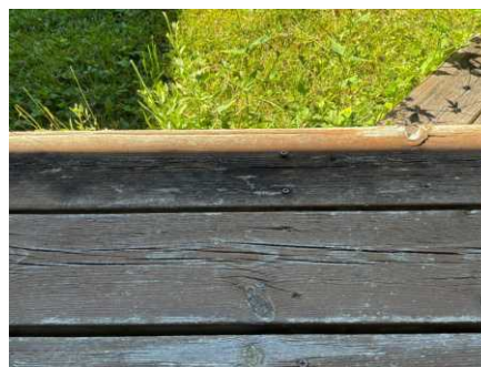
Eksempel på skruer som stikker opp.
