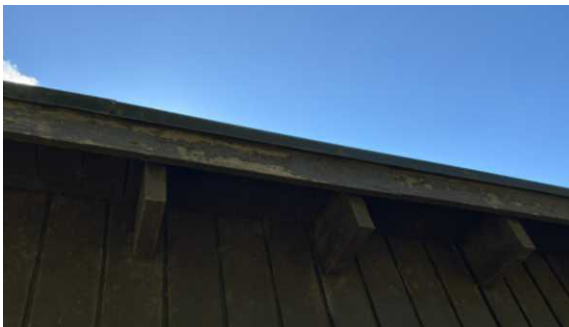
Avflasket overflatebehandling.
