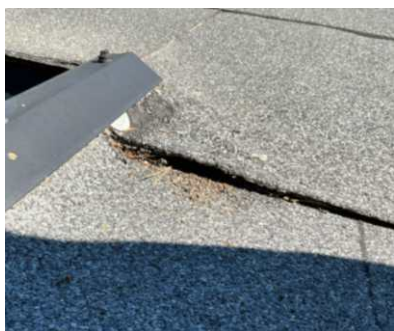
Overlapp/skjøt på taktekingen.
