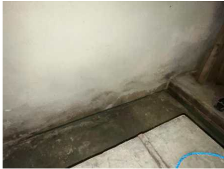
Del av rom under terreng.
