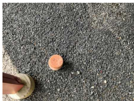
Utvendig stakeluke til avløp.
