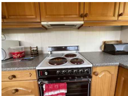
Montert avtrekk over komfyr.
