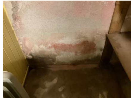
Del av rom under terreng.
