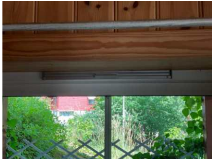
Eksempel på montert ventil i vindu.
