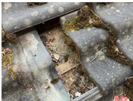
Del av takteking. Takstein er flyttet på.
