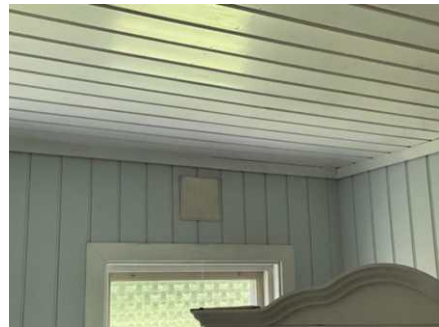
Eksempel på montert ventil i vegg.
