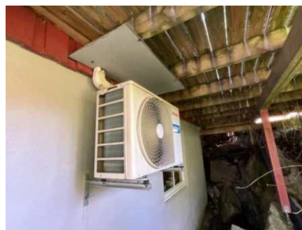
Varmepumpe ytterdel.
