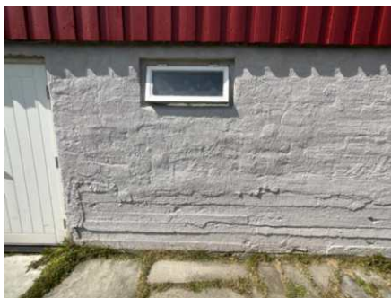
Del av grunnmur. Eksempel på sprekke/riss.
