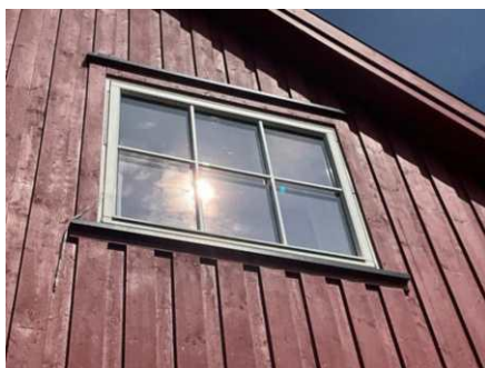
Eksempel på vindu i yttervegg.
