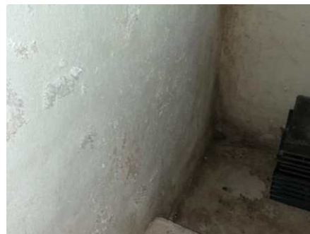
Del av rom under terreng.
