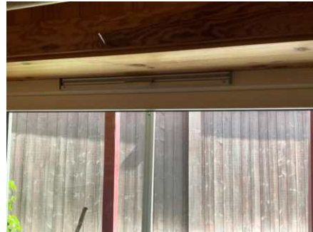
Eksempel på montert ventil i vindu.
