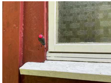
Stikkontroll på vinduer er utført.
