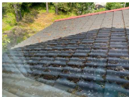
Del av takteking. Takstein er flyttet på.
