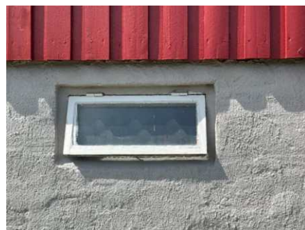
Eksempel på vindu i yttervegg.
