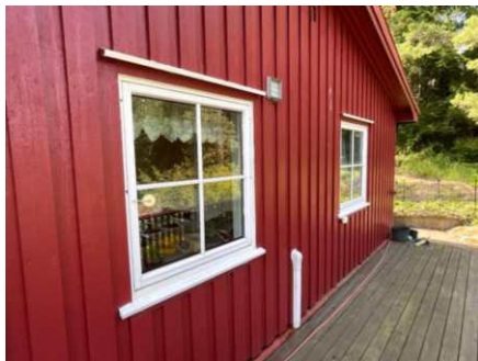
Eksempel på vindu i yttervegg.
