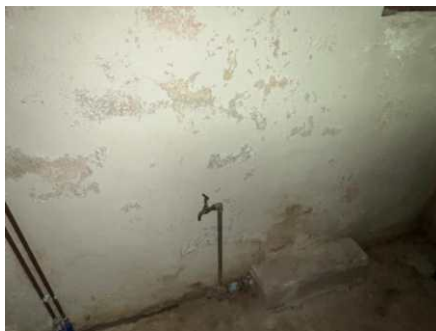
Del av rom under terreng.
