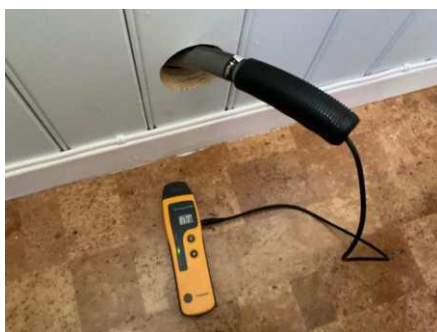
Hull for kontroll av fukt.
