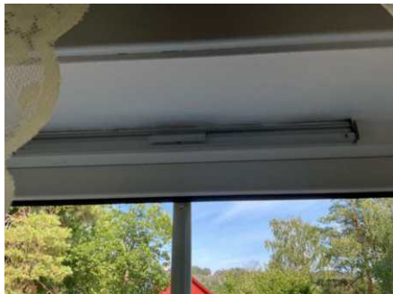
Eksempel på montert ventil i vindu.
