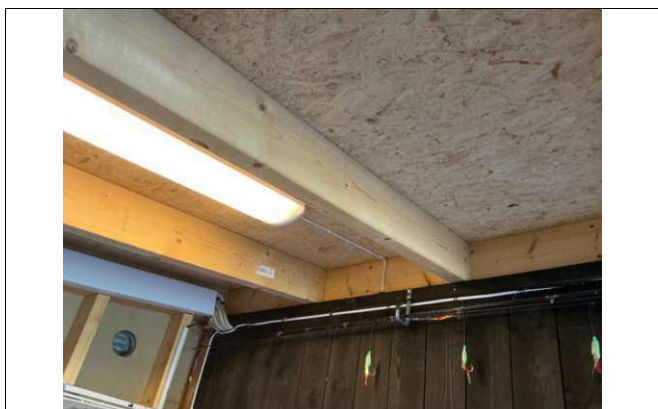
Ingen synlige lekkasjer registrert ved befaringen
