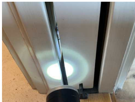
Inspeksjon via utsparing til skyvedører
