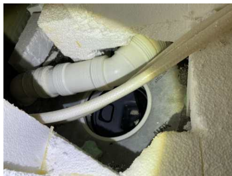
Synlig membran i sluk under badekar
