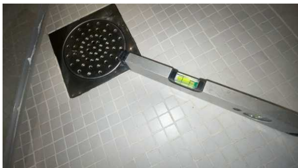
Fallforhold målt i retning sluk.
