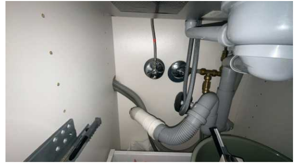
Rørproplegg ved underskap ved vaskemaskin.
