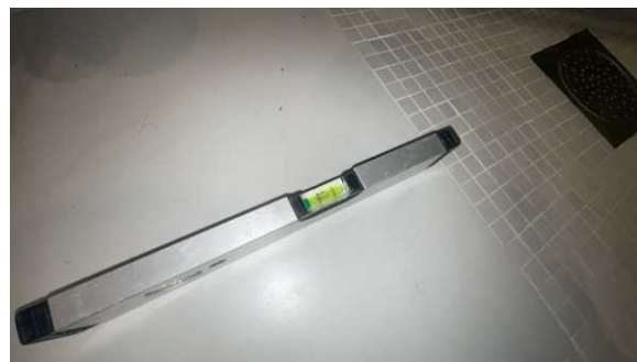
Fallforhold målt i retning sluk.
