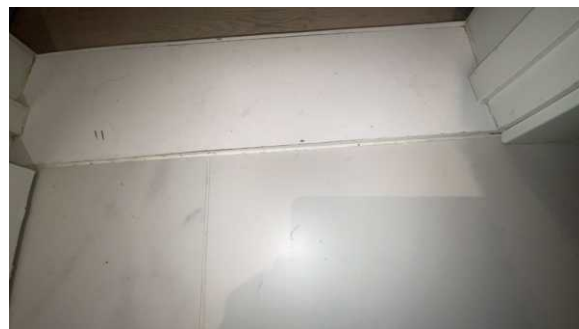
Overgang ved dørterskel.
