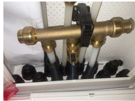
Rørproplegg ved underskap ved vaskemaskin.
