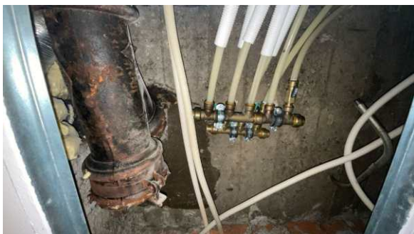
Avløpsrør over himling på baderommet til venstre i bildet.
