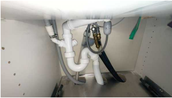
Rørproplegg ved underskap på kjøkken.
