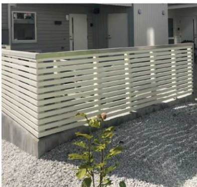
Eksempel på rekkverk med toppbord i aluminiumsbeslag.
