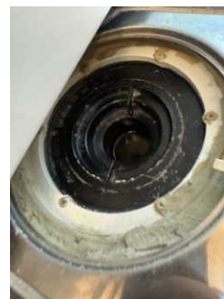
Bilde av hjelpesluk utenfor dusjsone.
