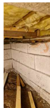
Provisorisk understøttelse av bærestokk og bjelkelag.
