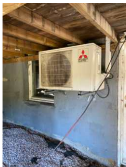
Utvendig del av varmepumpe i stue.
