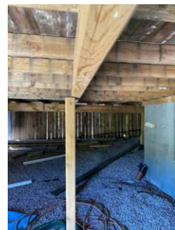
Forskjøvet stolpe under bærebjelke.
