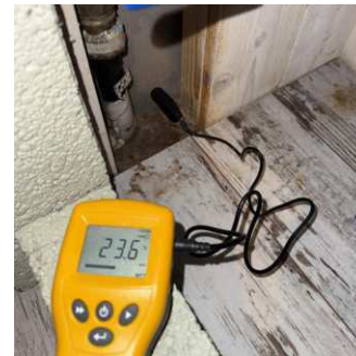
Fuktmåling ved stoppekran
