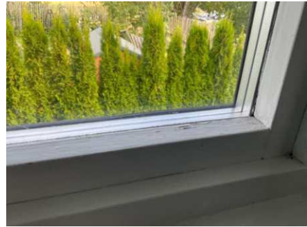
Innvendig kondensering.
