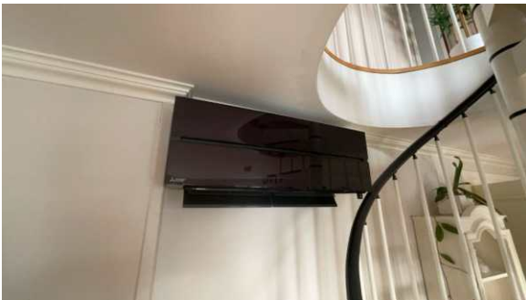
Varmepumpe, innvendig komponent.
