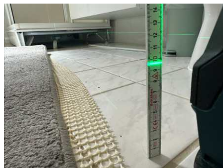
Nivellering av gulv ved dørterskel.
