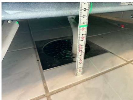
Nivellering av gulv ved sluk i dusjsone.
