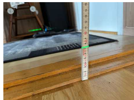
Nivellering av etasjeskille mot øst på stue i 2.etasje.
