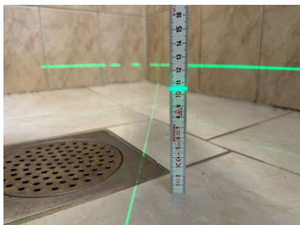
Nivellering av gulv ved sluk i dusjsone.
