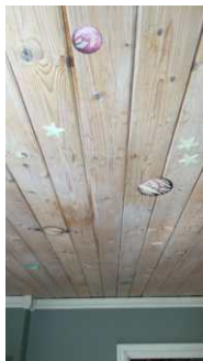
Skjolder i tak soverom 1.etg, mot sør (tørt ved måling).
