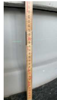
18mm gjennom vinterhage i underetasje.
