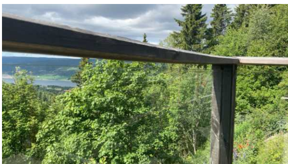
Heng i topprekke og innfesting av glass.
