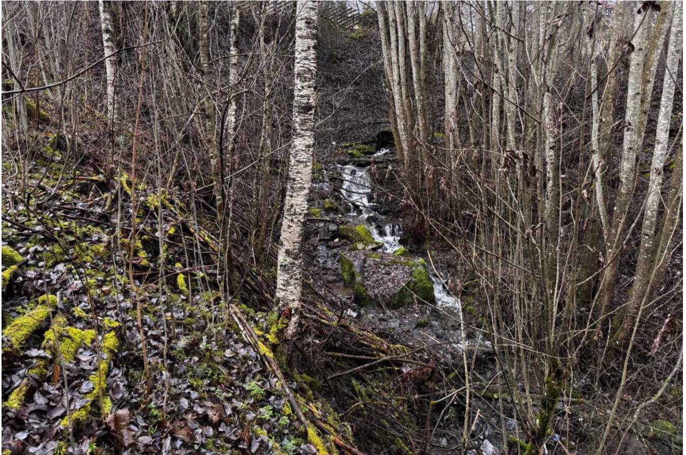
Figur 11 Infopunkt 1. Ved kartlagt område drenerer Kalvsjøbekken ut av dreneringsrør, dimensjon 700mm. Bekkeløpet er veldefinert og rettlinjert nedstrøms. Bilde av Skrið as.
