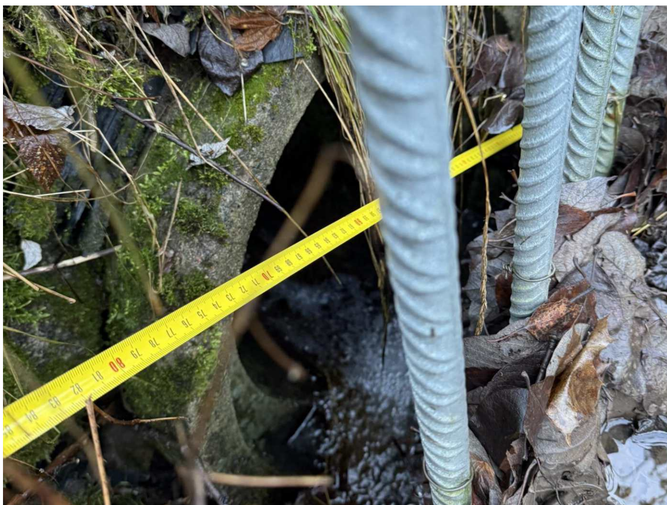
Figur 13 Infopunkt 3. Inntak oppstrøms dreneringsrør, oppmålt til 700mm i betong. Vurdert fra flyfoto til å være etablert rundt 1960. Bilde av Haavard Haakensen.
