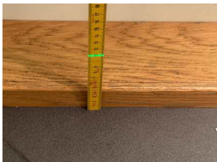
Fallforhold ca. 110 mm overkant gulv ved terskel
