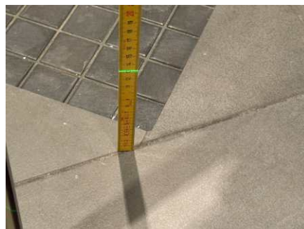
Fallforhold ca. 130 mm overkant gulv ved dusjsone
