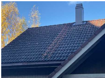
Taktekke fra byggeår.
