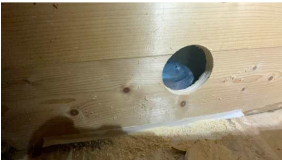
Dampsperre i vegg.
