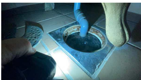
vann stiger rask i sluk. Skruer ikke skrudd ned.
