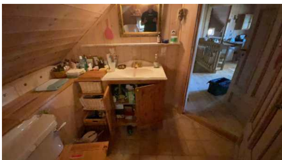
Uegnede materialer i tilknytting til våtzone.
