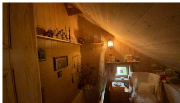
Uegnede materialer i tilknytting til våtzone.
