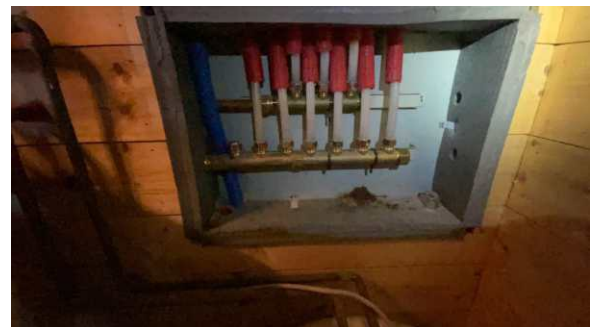
Vannfordeling varmtvann.
