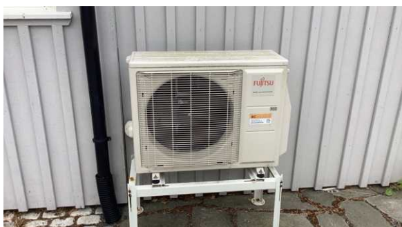
Luft til luft varmepumpe.
