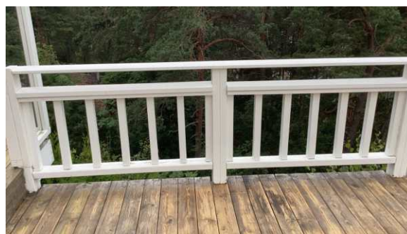
Store åpninger i rekkverket.
