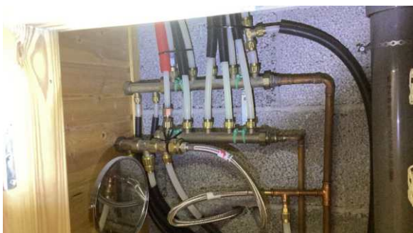
Ikke rørskap til rør i rørsystemet.
