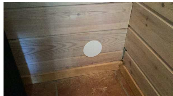
Hullet er plombert etter kontroll
