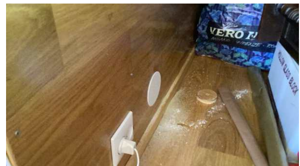
Hullet er plombert etter kontroll
