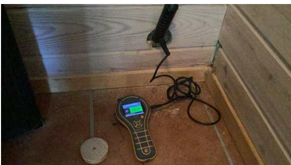
Normale forhold i yttervegg mot terreng i underetasjen.
