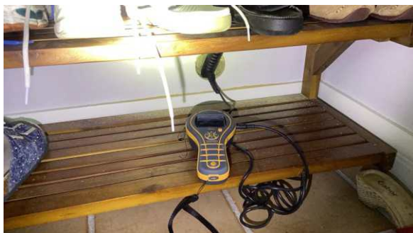
Ingen unormale forhold i veggen mellom vindfanget og badet.
