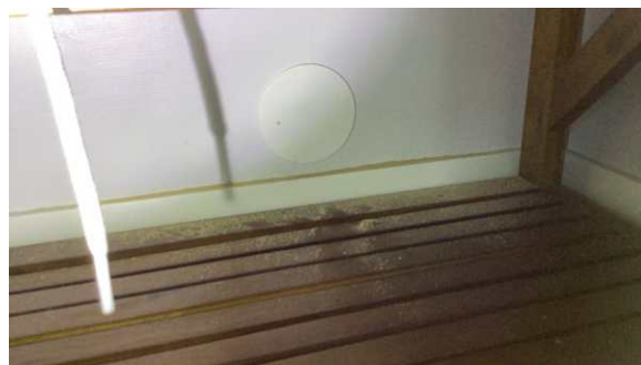
Hullet er plombert etter kontroll.
