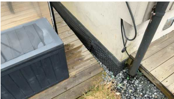
Synlig platon over terreng.
