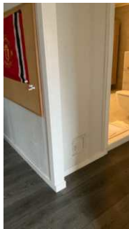
3 pipevanger er kledd igjen i nederste underetasje
