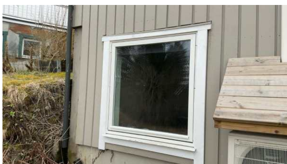
Flere nye vinduer i huset.
