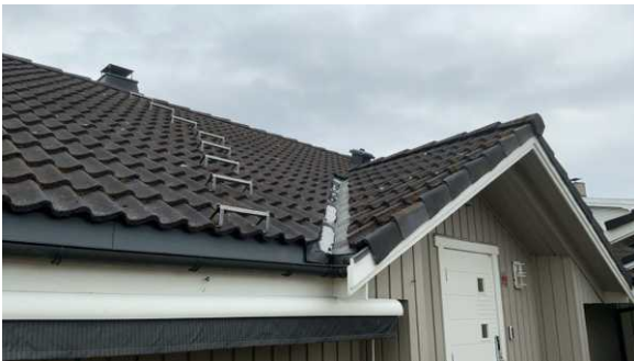
Avskalinger i plastbelegget på gradrennene
