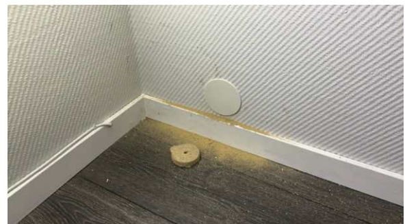
Hullet er plombert etter kontroll.
