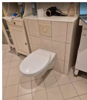
Det er ikke påvist tilfredsstillende løsning for å synliggjøre lekkasje fra innebygget sisterner.
