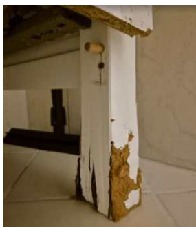
Det er påvist ødelagt innredning. (TG3)
