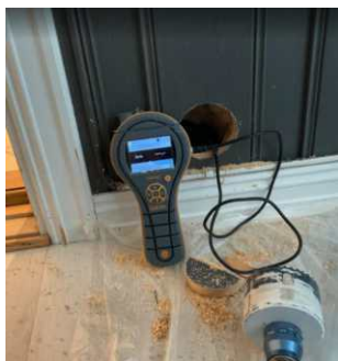
Ingen forhøyede verdier påvist ved fuktmåling
