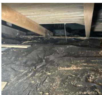
Det er områder på kaldloftet med vanskelig tilkomst som ikke er undersøkt.
