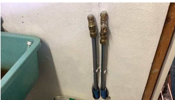
vannrør som ikke er i bruk.
