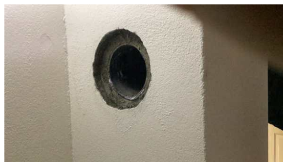
Hull etter tidligere vedovn i underetasjen.
