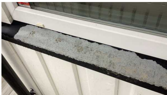
Avskalinger på beslaget til stuevinduene.
