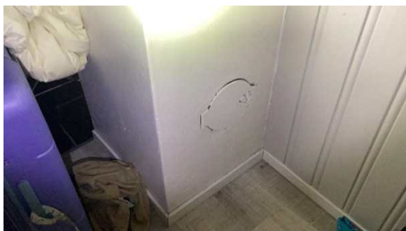
Sotluke for nær brennbart materiale.
