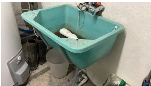
Utslagsvask i plast på vaskerommet.
