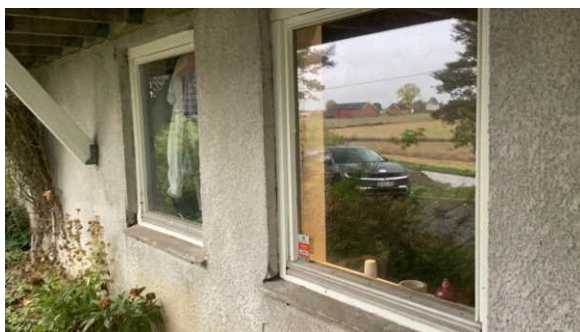
Vinduer fra byggeåret i underetasjen.
