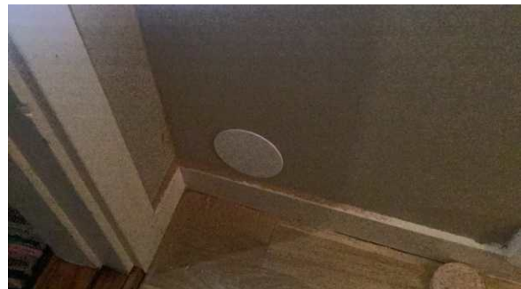
Hullet er plombert etter kontroll
