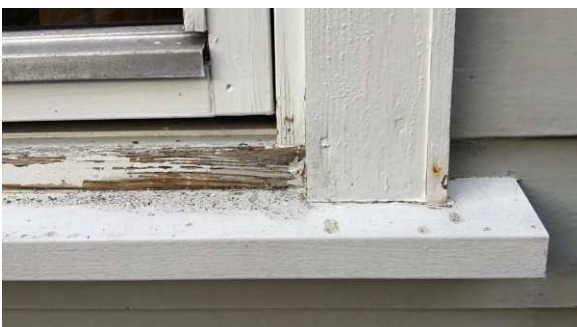
Utvendig belistning helt ned til vannbrettet.
