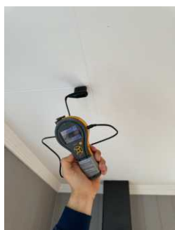
Ved søk med fuktindikator ble det ikke påvist forhøyede fuktverdier
