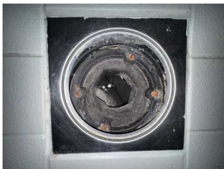
Eldre plastsluk med stakemutter
