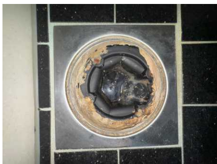
Plastsluk med stakemutter fra 1980-tallet
