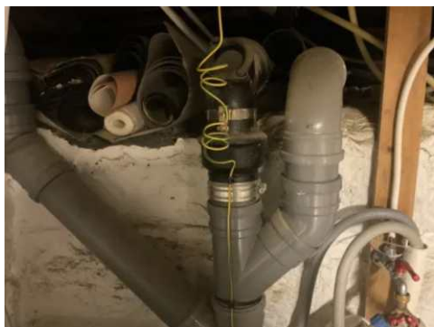
Deler av avløpsnett med støpejern.
