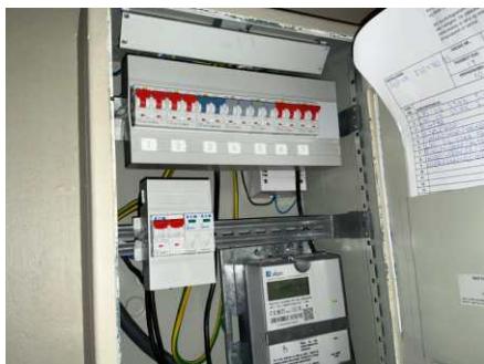
Automatsikringer i sikringsskap plassert i gang i 1. etasje.
