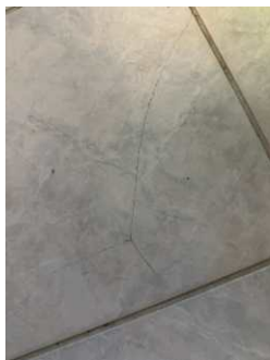
Manglende membran ved varmtvannstank
