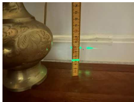
Nivellering av gulv på stue/kjøkken i kjeller
