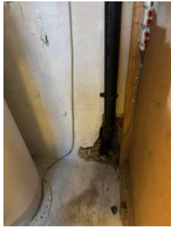
Manglende membran ved varmtvannstank
