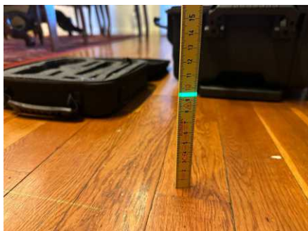
Nivellering av gulv på stue/kjøkken i kjeller
