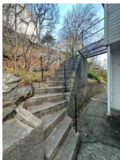
Situasjonsbilde utvendig trapp mot nord.
