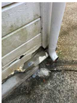
Vann fra taknedløp er ført ned langs betonggrunnmur
