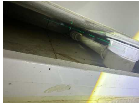
Utettheter ved rørgjennomføring under dusjkabinett.
