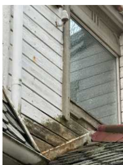
Situasjonsbilde bordkledning ved takoppbygg mot nord
