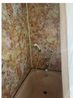
Overgang mellom gulv og våtromsplater.
