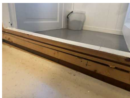
Overgang mellom gulv og terskel ved dør
