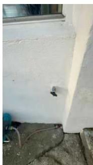
Vannutkaster på yttervegg mot øst.
