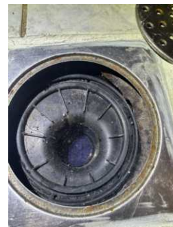
Utettheter ved rørgjennomføring under dusjkabinett.
