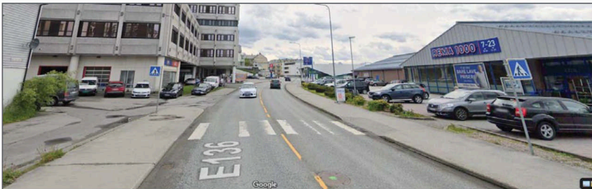
Figur 5 Gangfelt i nedre Strandgate. Dårlig plasserte og feilvendte gangfeltskilt, kun strøllys i kryssingspunktet. Fortau på nordsida er for lavt (foto: Google Street View 2019).
