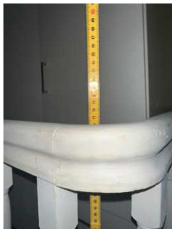
Rekkverkshøyde er målt til å være 76cm.
