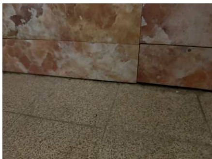
Overgang mellom gulv og våtromsplater.
