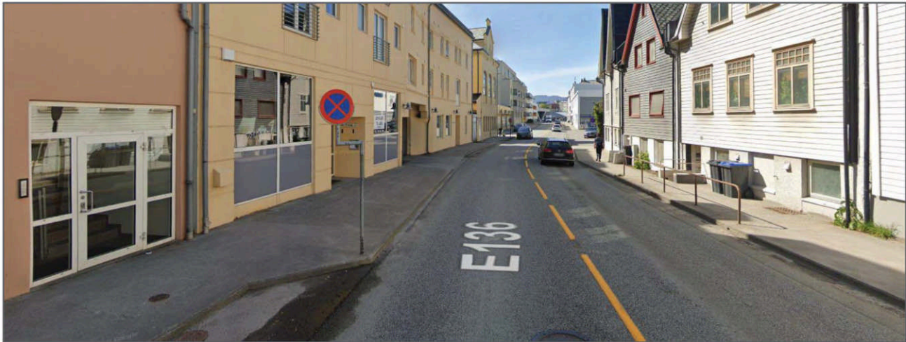
Figur 12 Nedre Strandgate i retning vest like vest for Aspegata. Behov for både veggssone og møbleringssone? (foto: Google Street View 2019)
