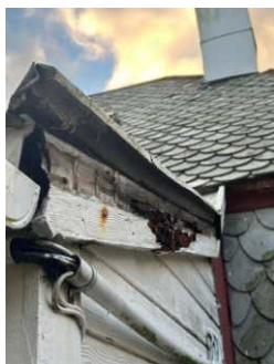
Utettheter ved beslagsløsning og råteskader på vidskibord mot nord.
