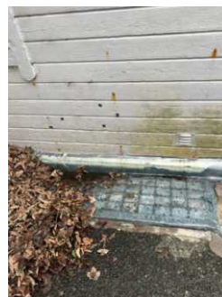
Situasjonsbilde forsøk tetting av vann ved betonggrunnmur
