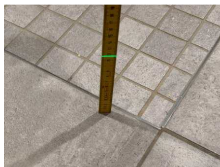
Fallforhold ca. 117 mm overkant gulv ved dusjsone
