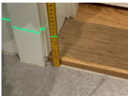
Fallforhold ca. 107 mm overkant gulv ved terskel
