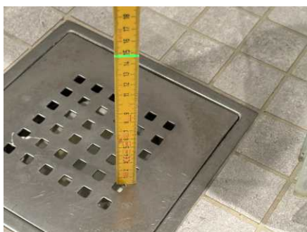
Fallforhold ca. 147 mm topp slukrist i dusjsone
