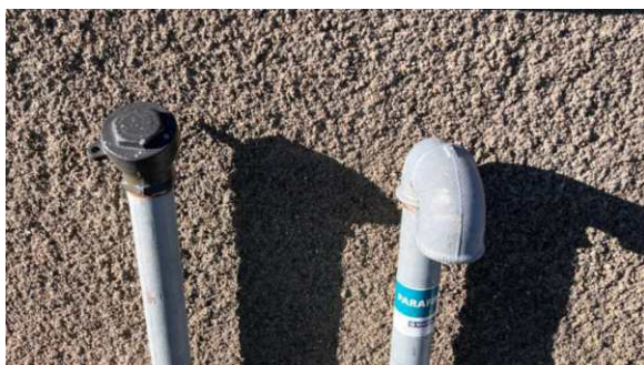
påfylling, lufting, oljetank
